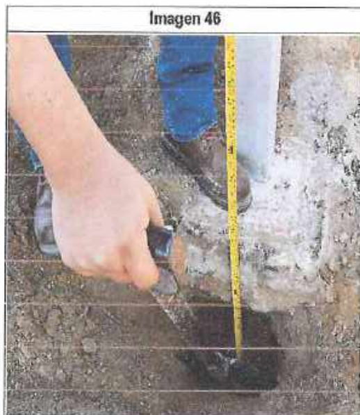
II.EE. n.° 80994 Base de concreto de 43cm no cumple con los términos de referencia que indica de 70cm. Fecha: 4 de agosto de 2020 Lugar: Distrito de Paiján, Provincia Ascope.
